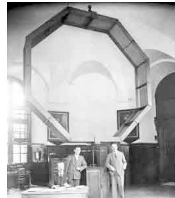
Bureau international de l'heure (BIH) : salle d'enregistrement de la tour de l'est avec son antenne de réception des signaux horaires. © Observatoire de Paris
